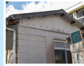
↑懇談の様子 ↑屋根の素材にアスベスト使用疑い 全写真はコチラ (学校名は伏せています)
